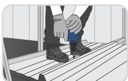
Passo 4 Fixe a telha nas terças com parafusos passantes, SEMPRE NA ONDA ALTA, NUNCA NA ONDA BAIXA.
